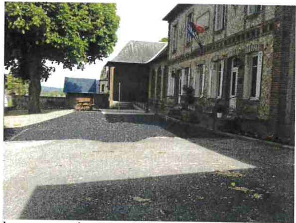
Le gros œuvre mise en accessibilité de la mairie est terminé
